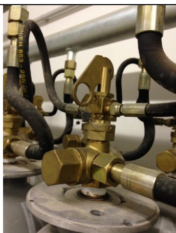
Dettaglio valvole bombole CO2
