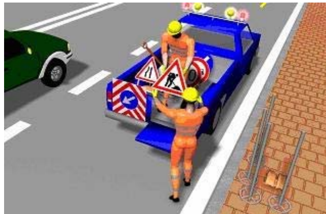
Descrizione: terza fase accantieramento stradale
