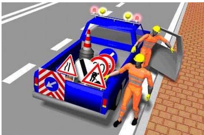
Descrizione: prima fase accantieramento stradale
