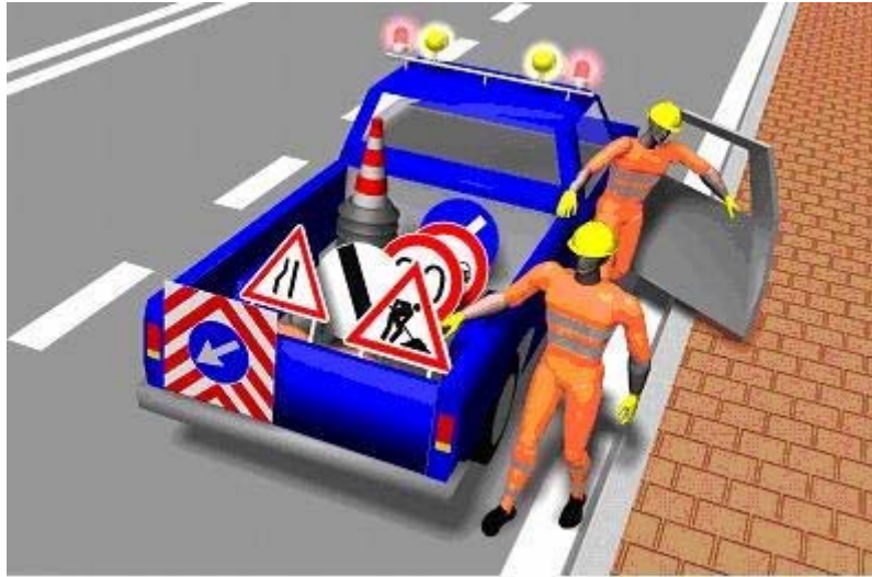
Descrizione: prima fase accantieramento stradale
