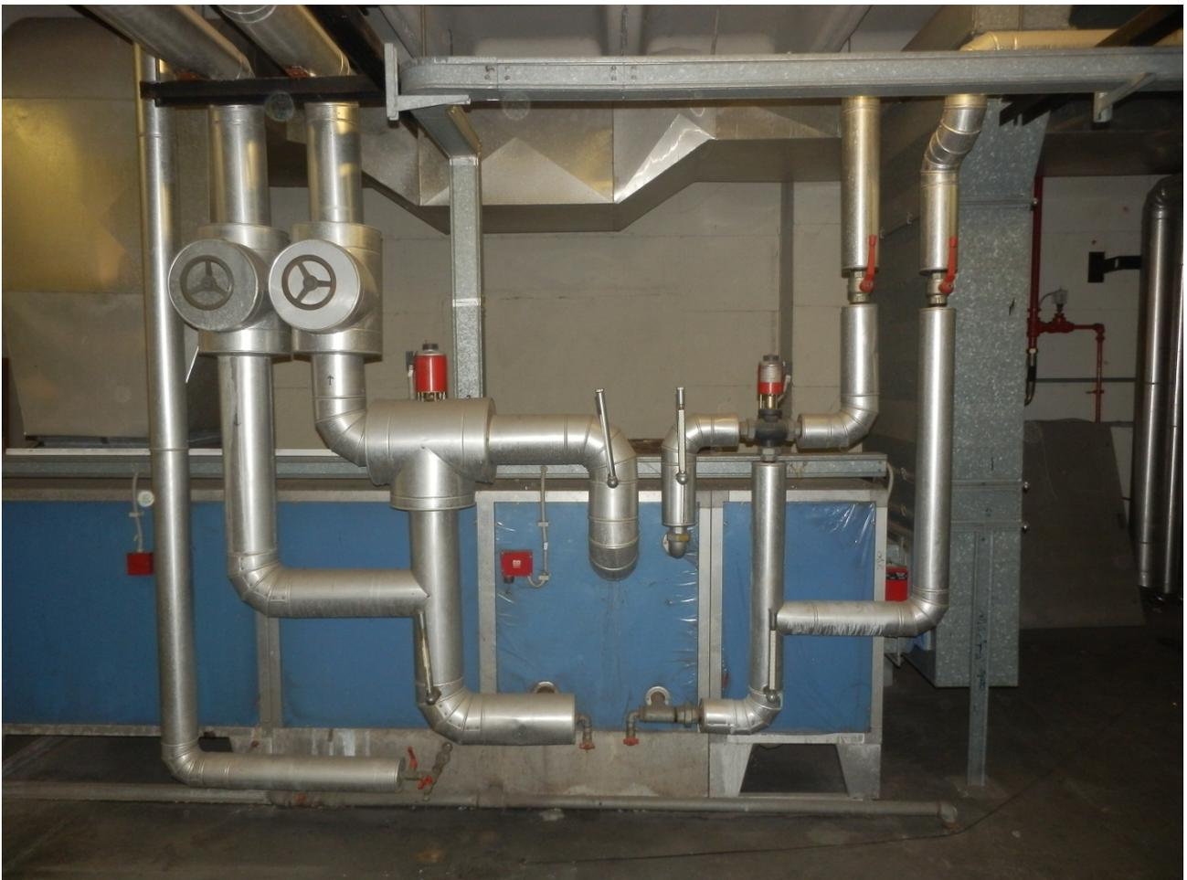
La nuova UTA dovrà essere riassembleata e ricollegata, previa modifica e rifacimento delle tubazioni, delle saracinesche, delle valvole e dei pezzi speciali, all'impianto acqua refrigerata, proveniente dai gruppi frigo, e all'impianto di riscaldamento proveniente dalla centrale termica posta sul tetto.
