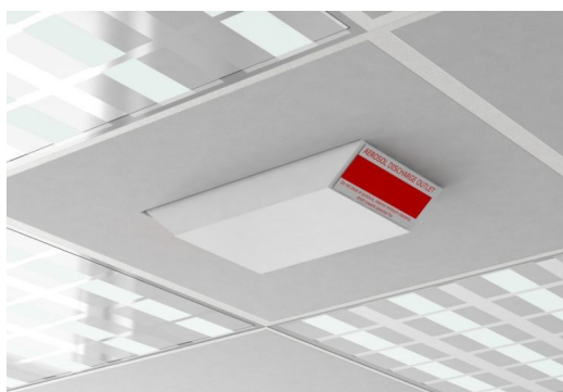
Fig. 1 Esempio di fissaggio a controsoffitto
