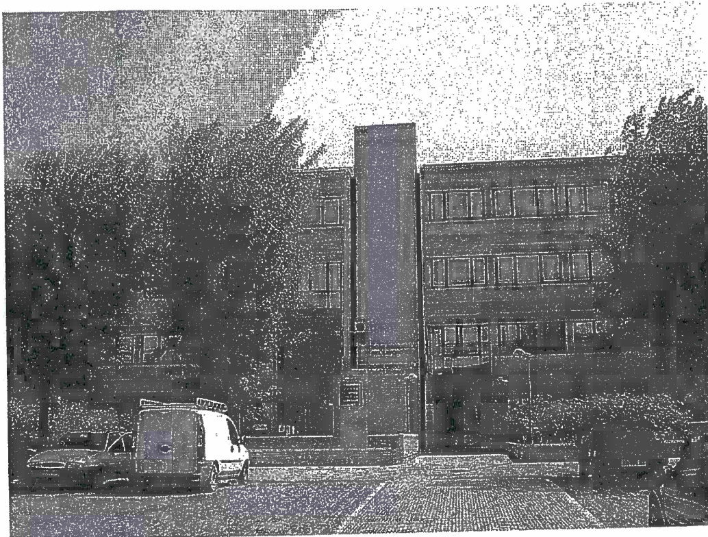
Foto n. 1 – veduta esterna dell'edificio
