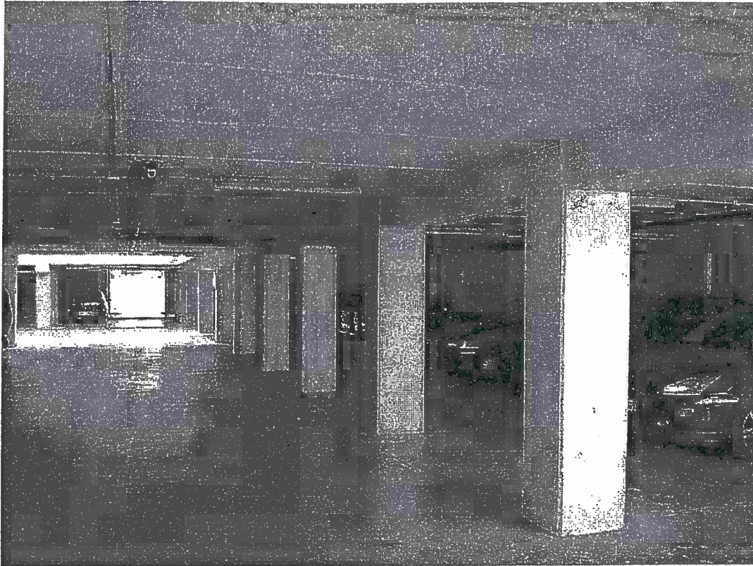
Foto n. 19 – autorimessa al piano interrato
