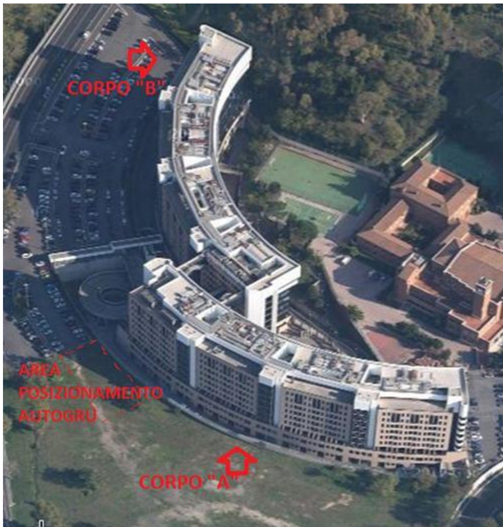
COMPLESSO CON EVIDENZA DELL'AREA PUBBLICA DOVE POSIZIONARE L'AUTOGRU ( FOTO 3)
