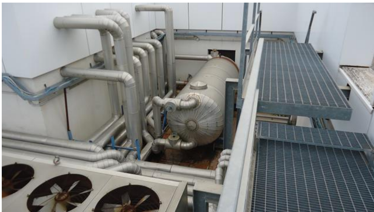
SERBATOIO ACCUMULO DA RIMUOVERE CORPO "B" ( FOTO 7)
