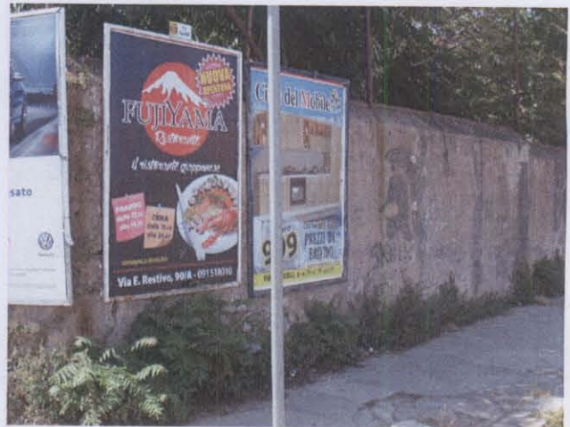
Muro tipo F – foto F4
