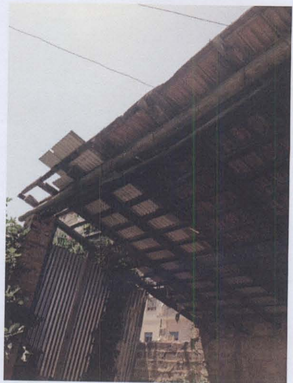
Tettoia – foto T3
