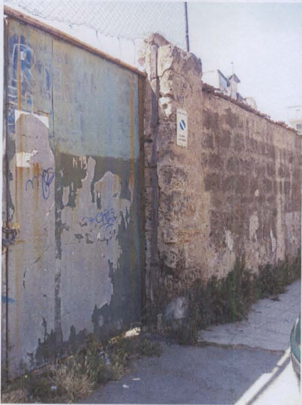
Muro tipo C – foto C1
