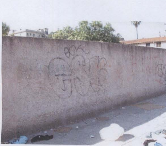
Muro tipo D – foto D3
