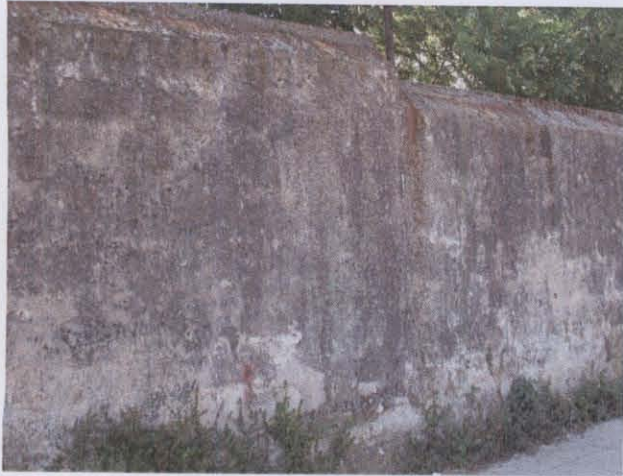
Muro tipo F – foto F1
