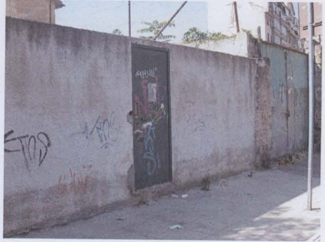
Muro tipo D – foto D2
