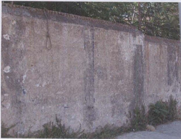
Muro tipo F – foto F3
