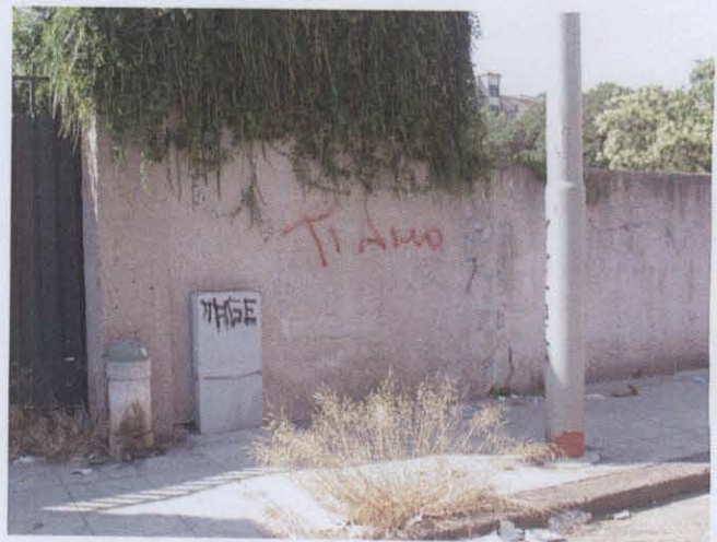
Muro tipo D – foto D4
