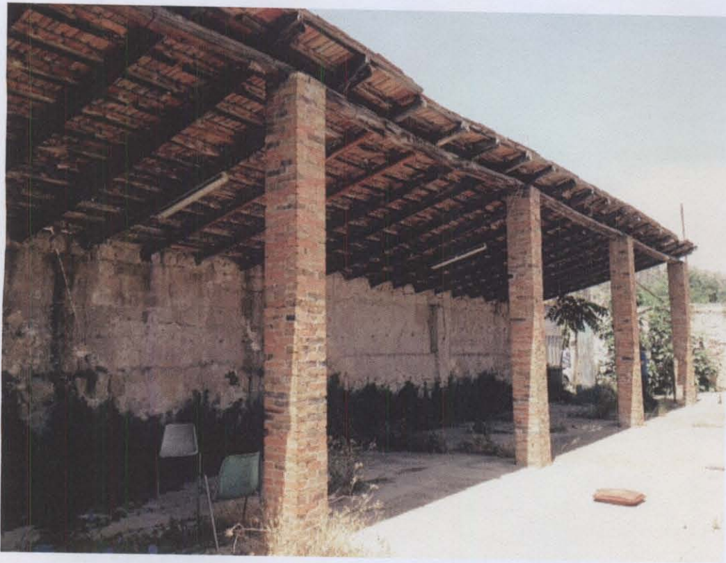
Tettoia – foto T1
