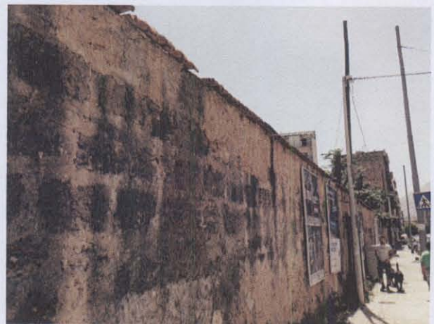
Muro tipo C – foto C4
