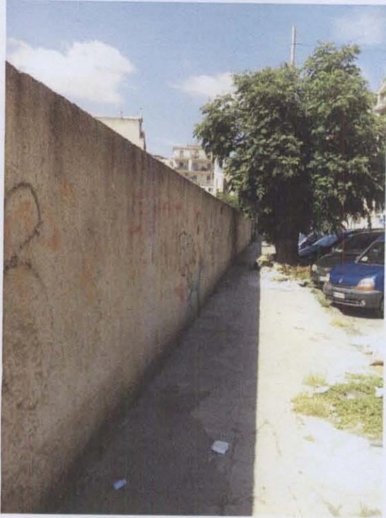
Muro tipo D – foto D1
