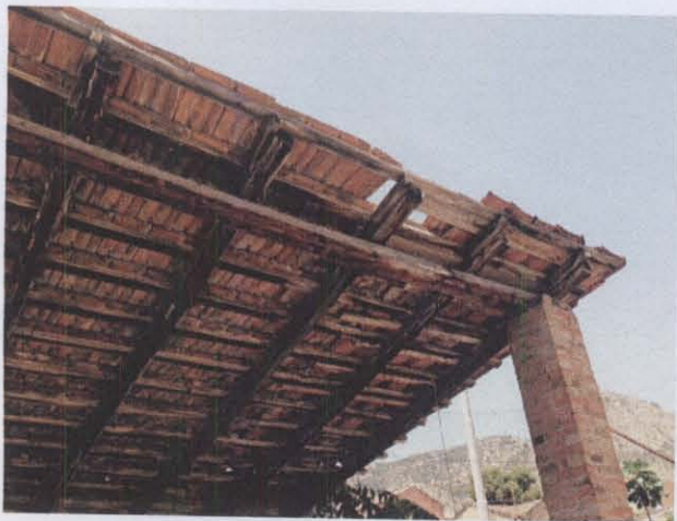
Tettoia – foto T2
