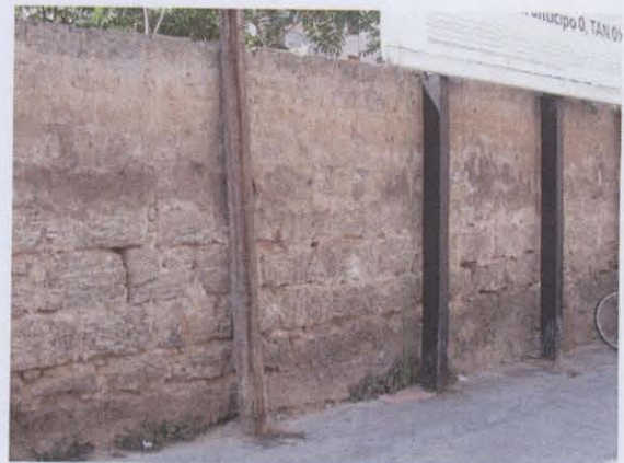
Muro tipo B – foto B4
