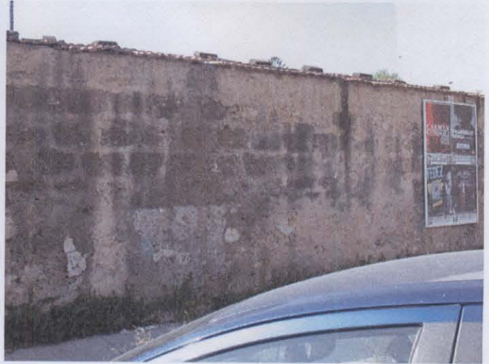
Muro tipo C – foto C2
