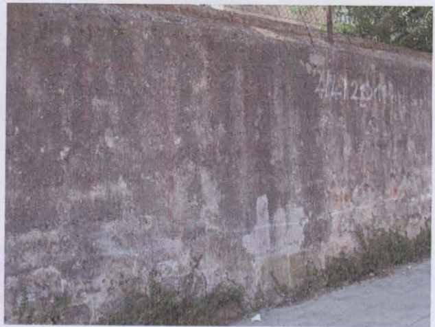
Muro tipo F – foto F2
