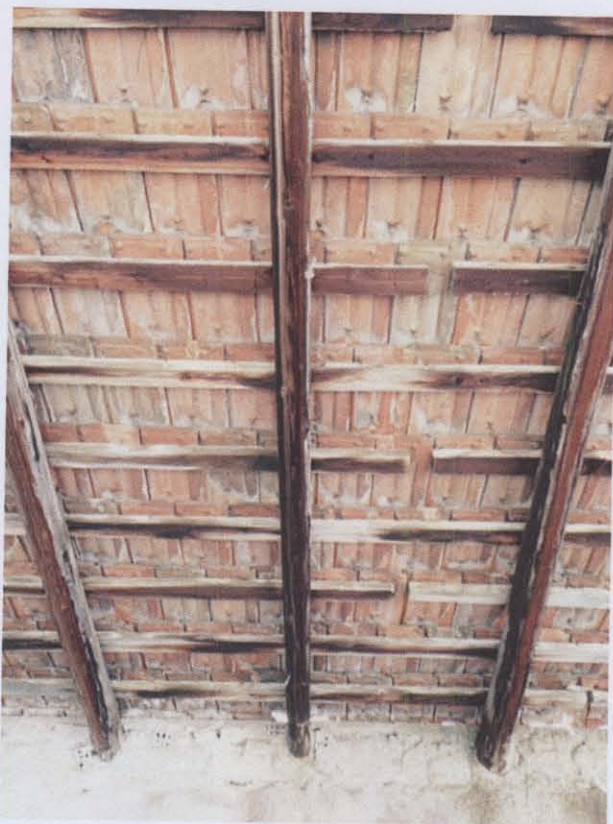
Tettoia – foto T5
