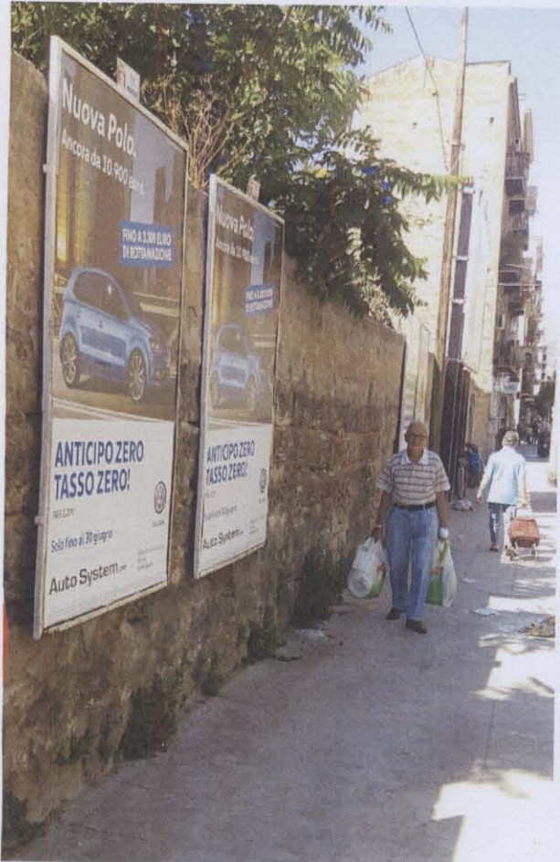
Muro tipo B – foto B3
