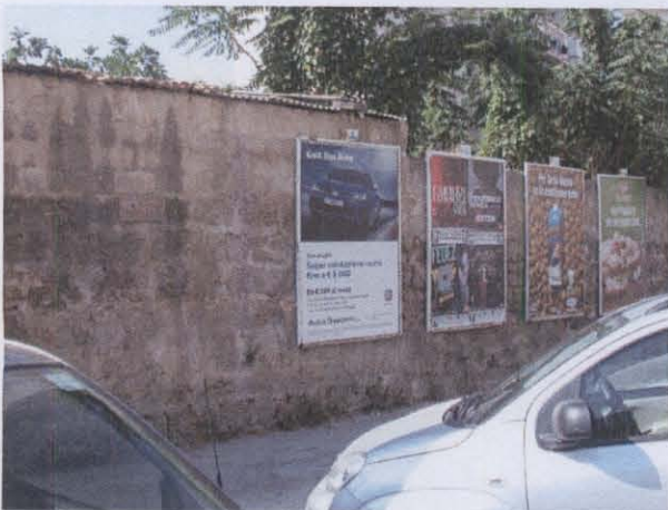
Muro tipo C – foto C3
