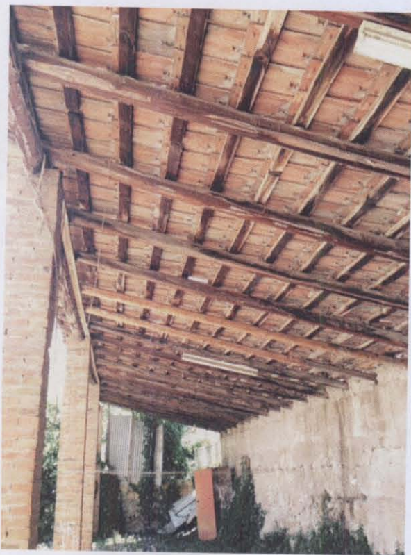
Tettoia – foto T4
