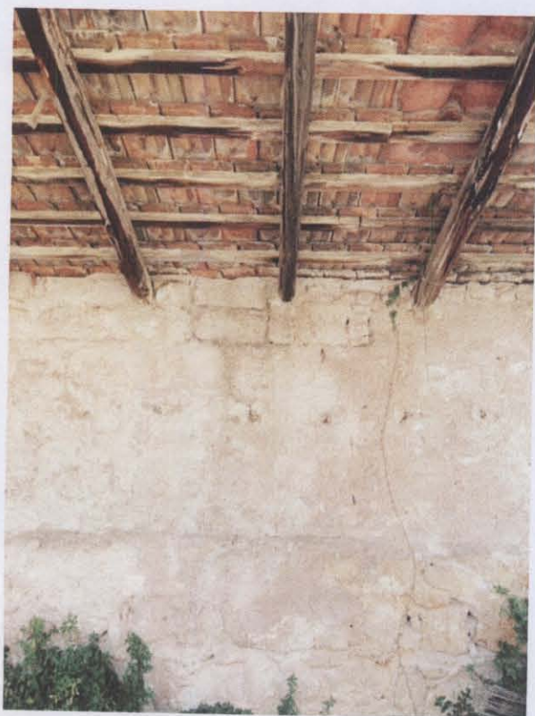
Tettoia – foto T6
