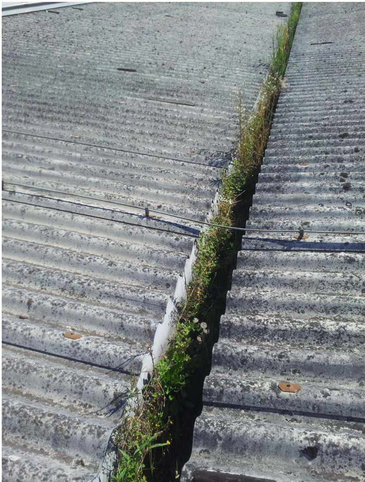
Foto n. 3 – Canale di raccolta perimetrali e lattennerie parapetti attuali
