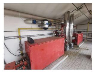
Oggetto principale dei lavori da appaltare è rappresentato dal rifacimento totale della centrale termica a partire dalla demolizione in loco dei generatori esistenti compreso rimozione dei bruciatori, e di ogni altro componente degli attuali impianti di produzione e distribuzione, per procedere al successivo rifacimento di una centrale termica per produzione di acqua calda ad uso per solo riscaldamento ad elevata efficienza.
