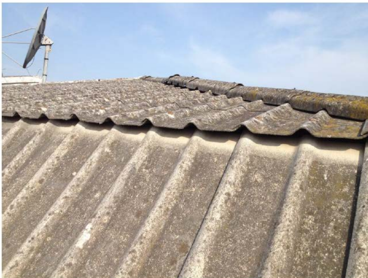
Foto 4 Falda SE lato Via Mazzini
