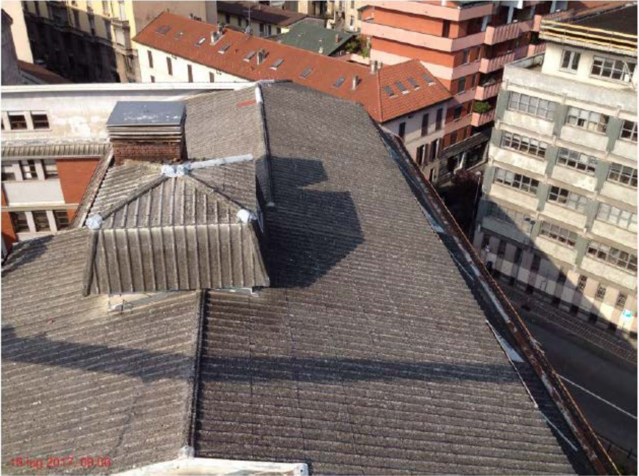
Foto 5 Vista d'insieme falde SE e SO
