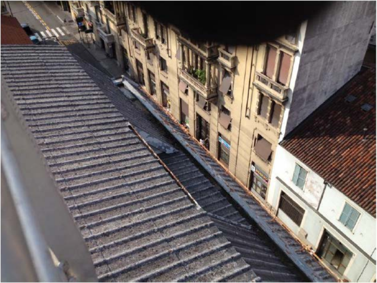
Foto 9 Falda SO: canale di gronda lato Via San Francesco
