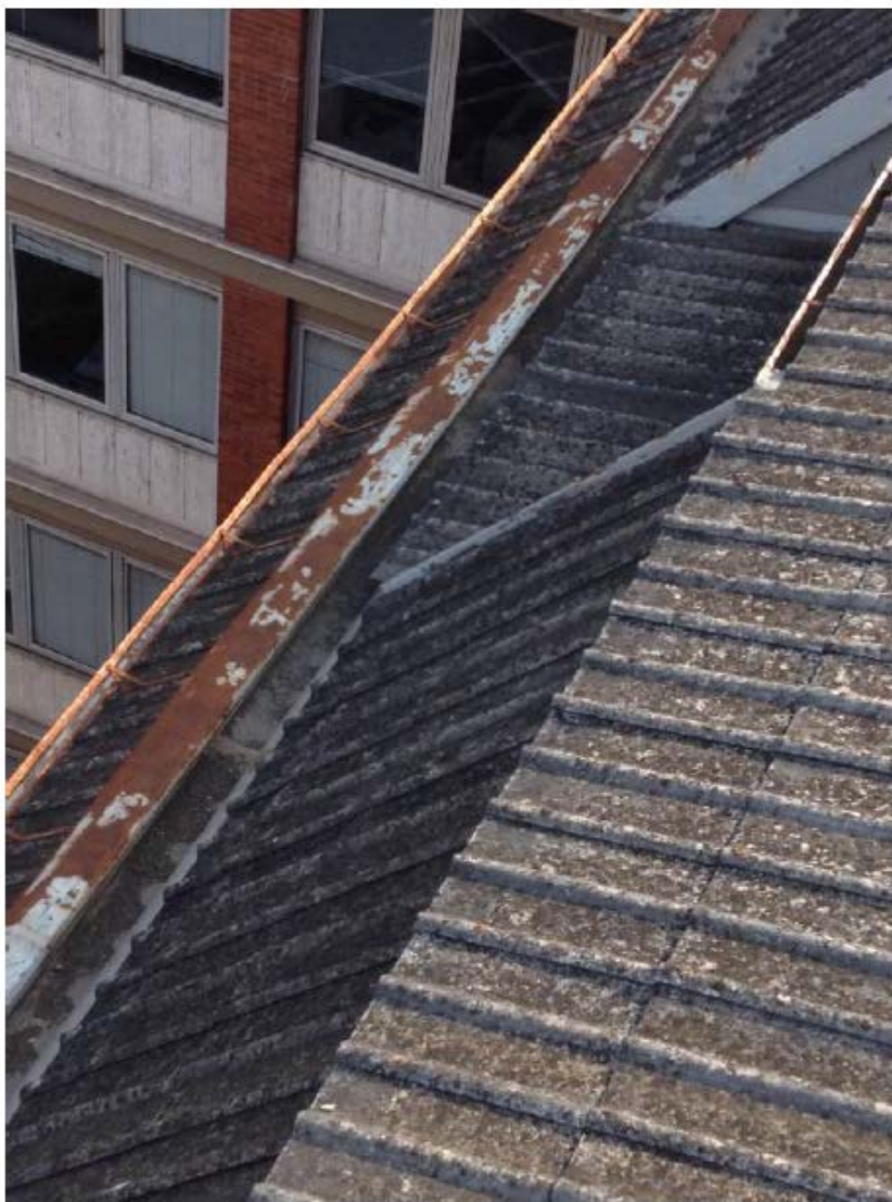
Foto 6 Canale gronda falda NO
