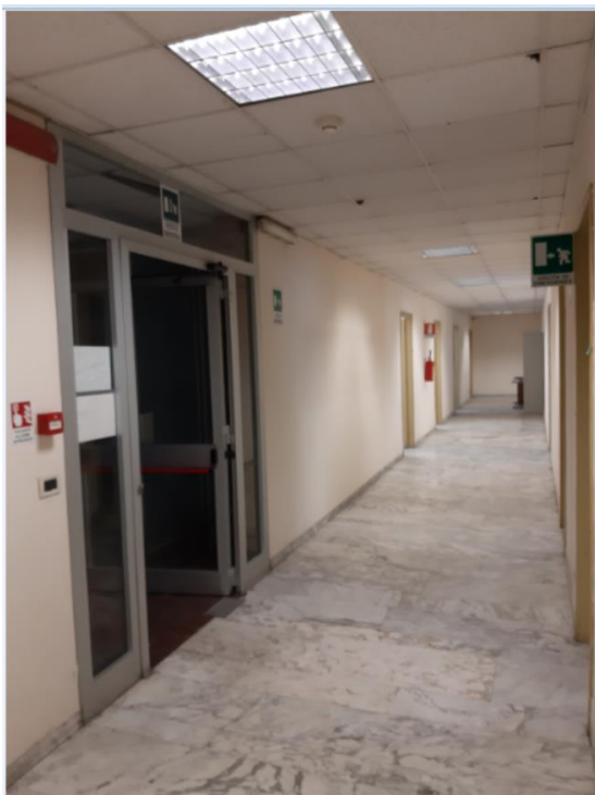
Corridoio e porte delimitazione -
