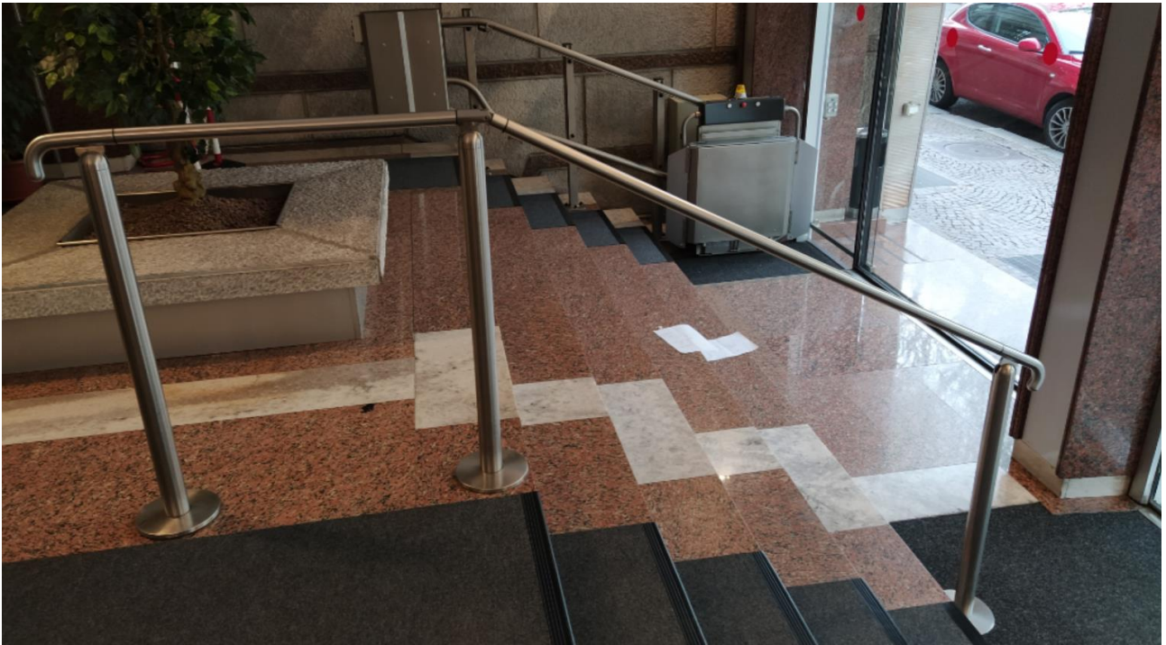
Particolare ingresso condominiale principale non utilizzabile dall'impresa
