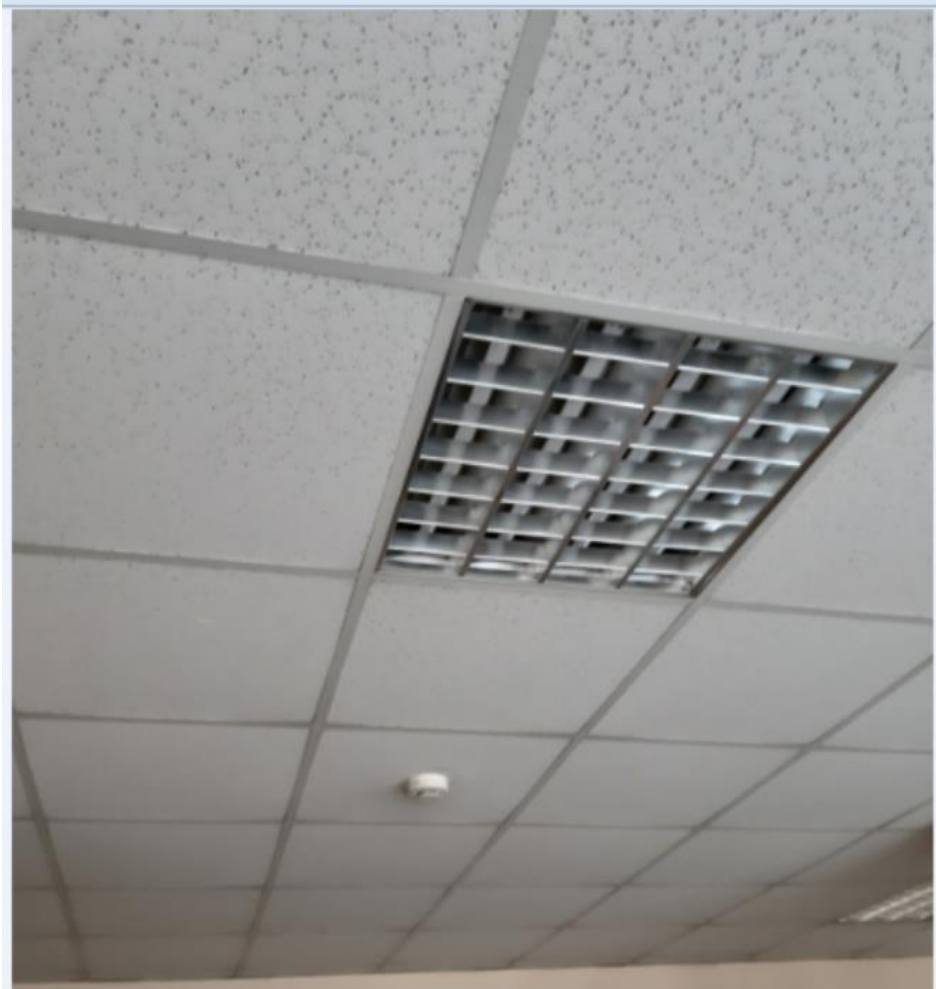
Controsoffitti, apparecchi illuminanti, rilevatori di fumo
