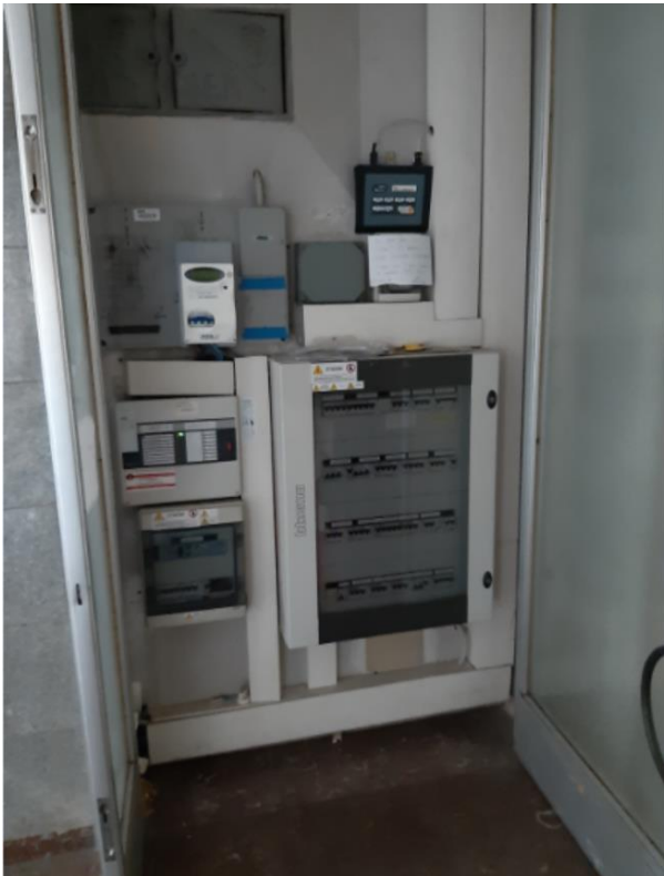
Quadro elettrico e centralina sistemi allarme al 1° piano
