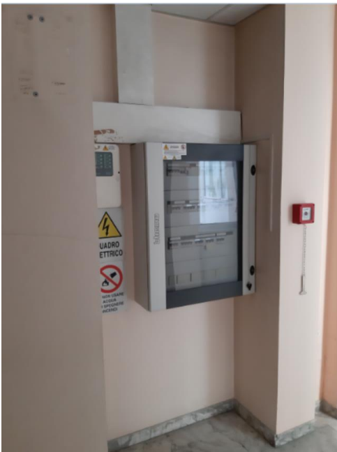
Quadro elettrico di piano e armadio Rack
