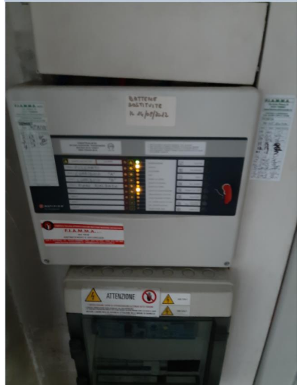
Quadro elettrico e centralina sistemi allarme al 1° piano
