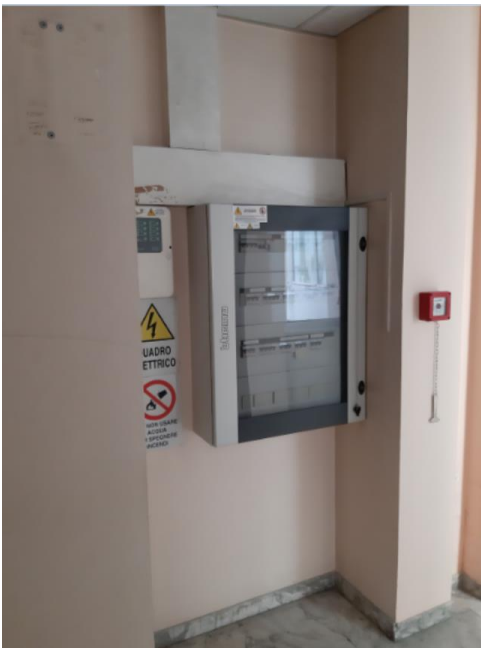
Quadro elettrico di piano e armadio Rack
