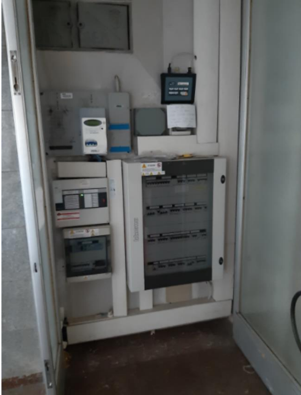
Quadro elettrico e centralina sistemi allarme al 1° piano
