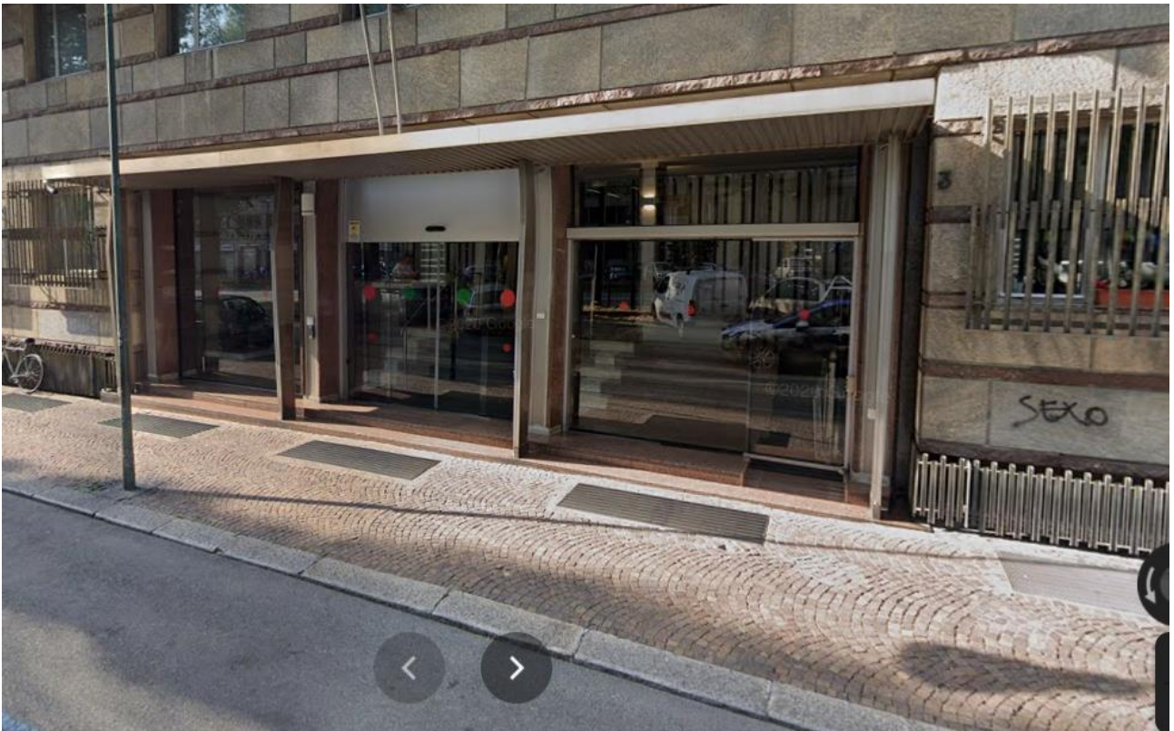
Ingresso principale del fabbricato
