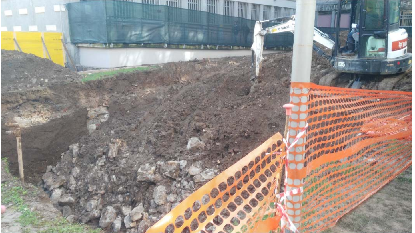
Fase di demolizione del primo muro
