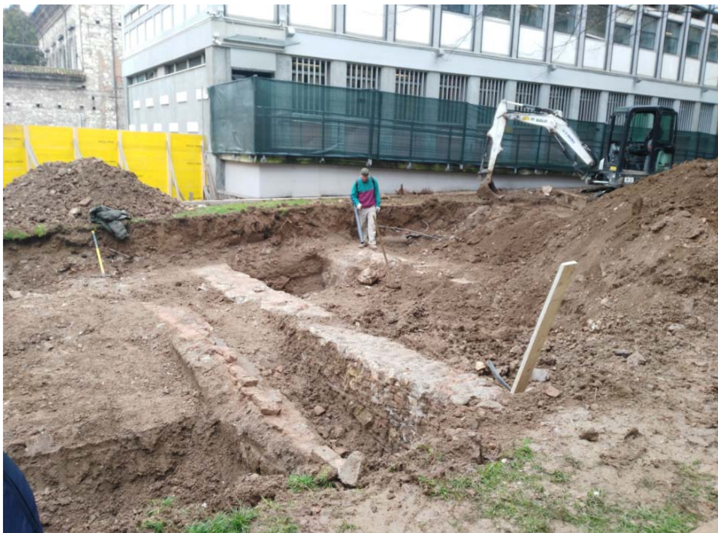
Operazioni di pulizia manuale dei manufatti
