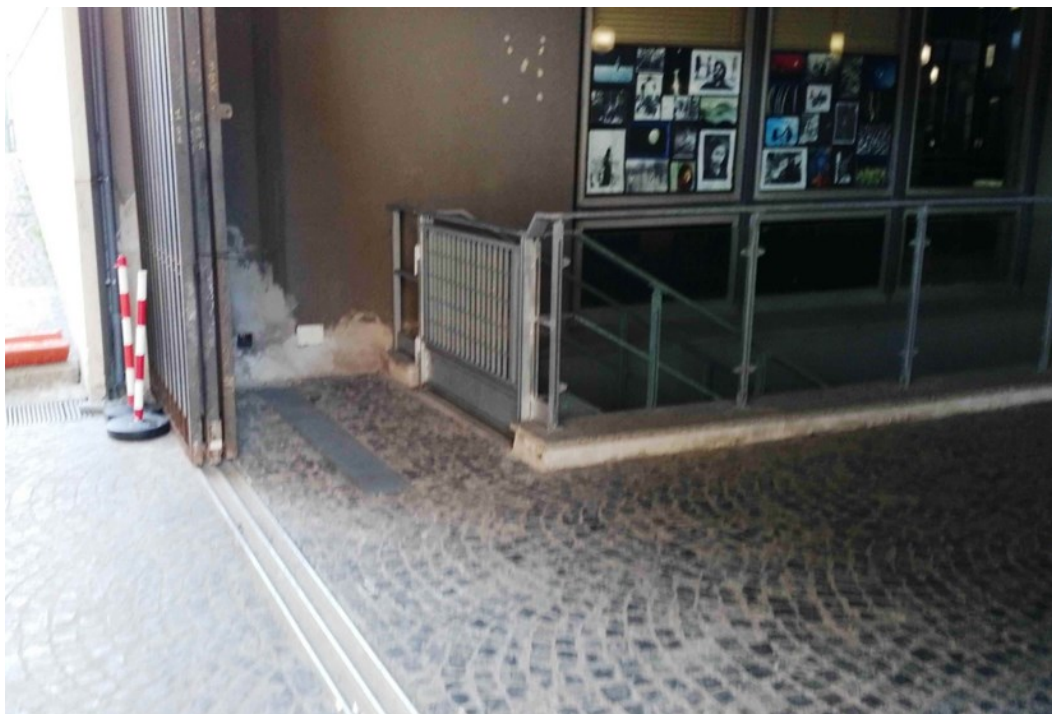
Figura 7: particolare del tunnel e dello sbarco della scala di emergenza
