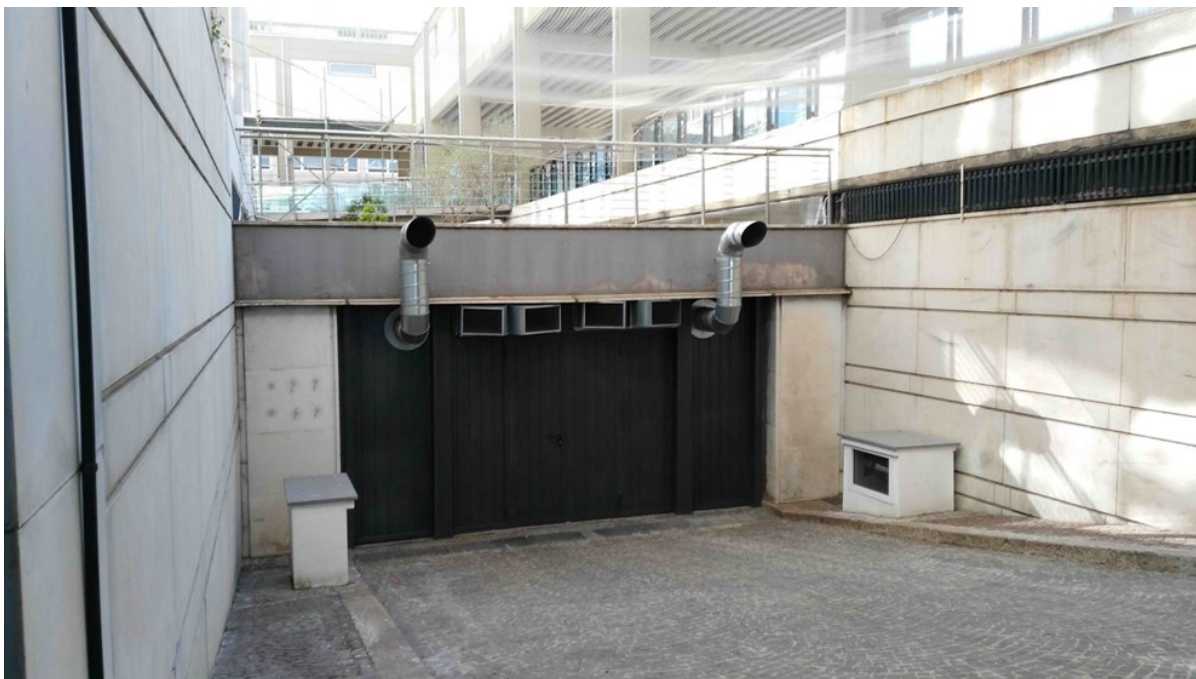
Figura 3: uscita secondaria della sala Campus a chiusura della rampa carraia
