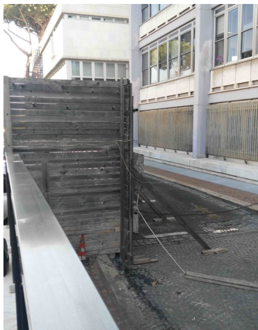
Figura 2: lato interno dell'inizio della rampa carraia
