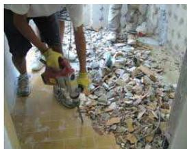
**Trattasi della demolizione di pavimentazioni di qualsiasi tipo, di rivestimento in maioliche e del sottostante massetto**
