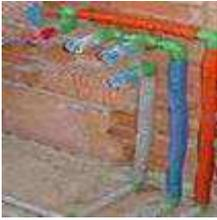
La fase lavorativa prevede la realizzazione della rete generale di distribuzione acqua fredda, posa tubazioni, colonne montanti di distribuzione di acqua fredda e calda ai singoli apparecchi del bagno.
