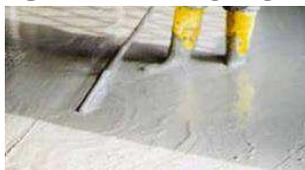
Trattasi della realizzazione di massetti in calcestruzzo semplice o alleggerito per sottofondo di pavimenti, formazione di pendenze, ecc.
