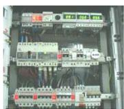
Esecuzione di lavori su quadri elettrici, ossia di una struttura assemblata contenuta in un involucro rigido, costituita da apparecchiature di interruzione, comando e controllo a bassa tensione, oltre che da sbarre, cavi, morsetti, segnalazioni e quanto necessario per la loro corretta interconnessione e per il relativo comando e controllo. Tale struttura ha la funzione di alimentare e, nel caso di guasti o manutenzioni, di scollegare elettricamente le utenze elettriche ad
