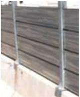
L'area interessata per il carico e scarico del materiale del cantiere deve essere delimitata con una recinzione, di altezza non inferiore a mt 2 realizzata con un efficace sistema di confinamento, adeguatamente sostenute da paletti fissati in plinti o pannelli.
