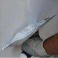
Esecuzione di intonacatura e rasatura interna su superfici sia verticali che orizzontali, realizzata a mano.
