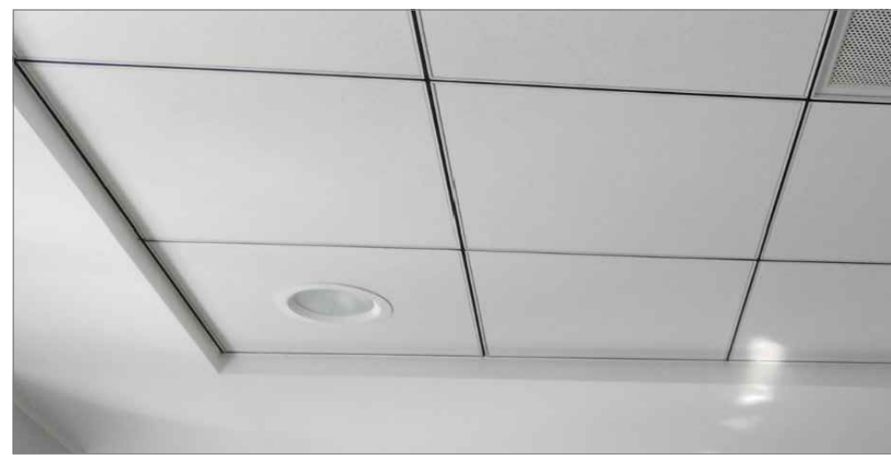
"Dettaglio indicativo" CONTROSOFFITTO in fibra con veletta e risvolto
