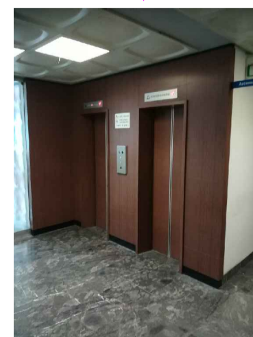
Sbarco ascensori C-D lato Romagnosi
