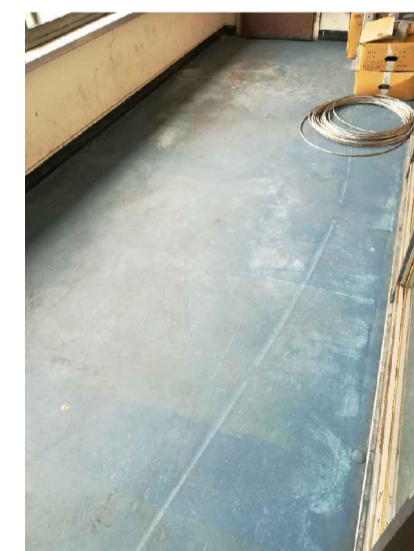
Pavimentazione in PVC esistente nel locale adiacente da bonificare
