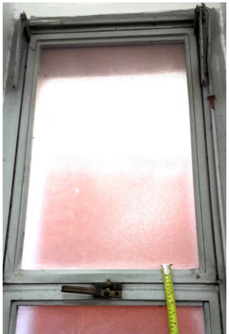
FINESTRA BAGNI – LATO INTERNO
