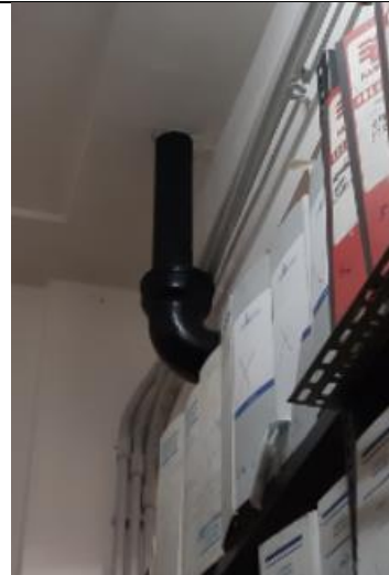
Foto 02 - con intervento soluzione C, particolare G
