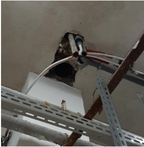
Foto 07 - con intervento soluzione D e B, particolare G
