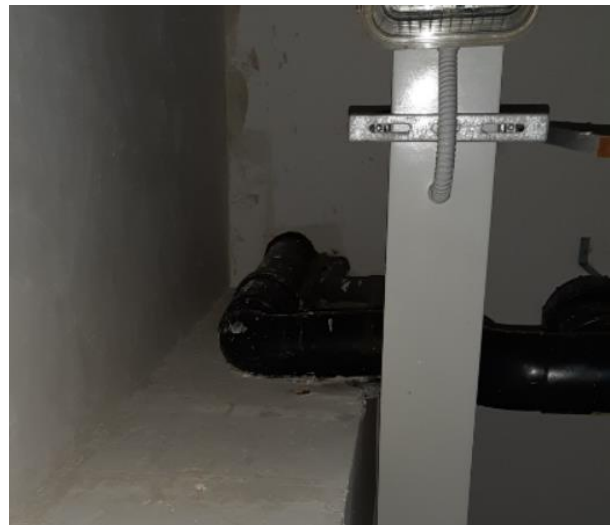
Foto 04 - con intervento soluzioni A e C, particolare G
