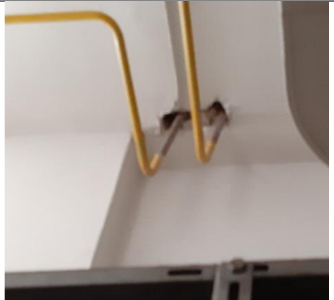
Foto 20 - con intervento soluzione D, particolare G + rimozione tubo in ferro
