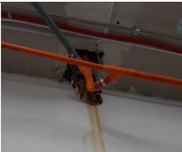
Foto 11 - con intervento soluzione D – A – C e B, particolare G + dismissione tubo in ferro orizzontale
