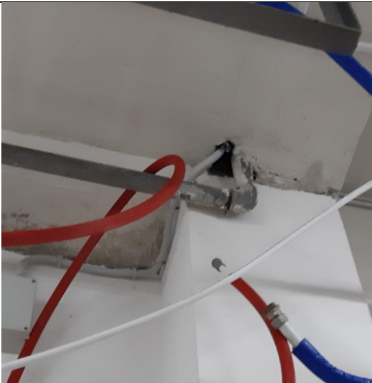
Foto 21 - con intervento soluzione D - B e C, particolare G + sistemazione tubo distribuzione acqua
