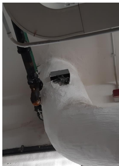
Foto 18 - con intervento soluzione D - A e C, particolare G + rimozione tubo coibentato
