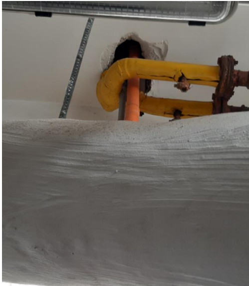
Foto 19 - con intervento soluzione D -B e C, particolare G + rimozione tubo in ferro
