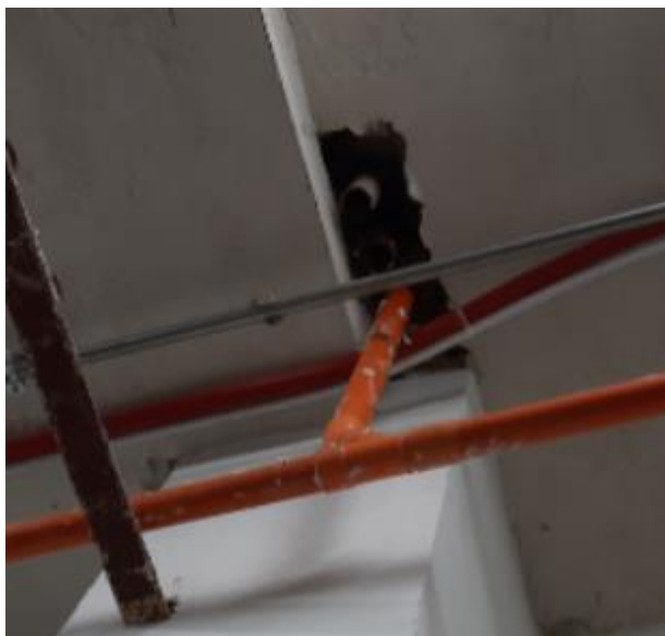
Foto 13 - con intervento soluzione D e A, particolare G
