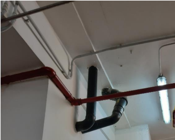
Foto 01 - con intervento soluzione C, particolare G
