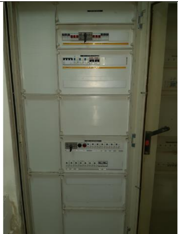
Foto 32 - Q06 lato SX, da dismettere
