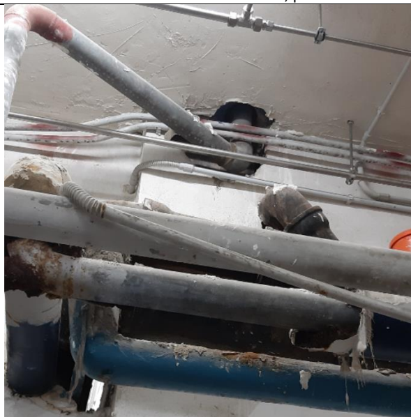
Foto 17 - con intervento soluzione D e C, particolare G + rimozione tubi in ferro
