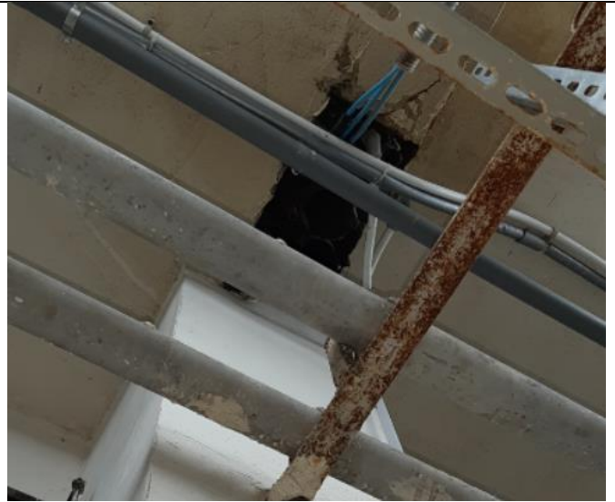
Foto 08 - con intervento soluzione D – C e B, particolare G + dismissione tubo in ferro orizzontale
