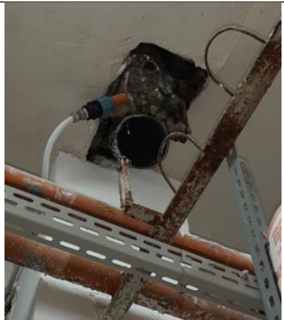
Foto 06 - con intervento soluzione D e B, particolare G
