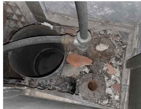
Interno cavedio con materiale da dismettere e solaio da liberare nell'interezza e riquadrare per l'inserimento della struttura con pannelli in lana di roccia
