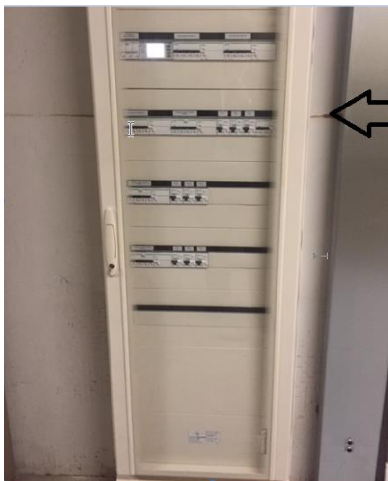
Quadro elettrico di alimentazione linee impianto e luci piani quarto, primo e rialzato
