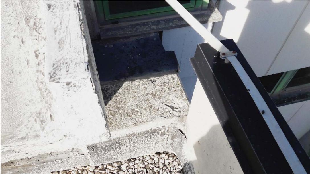
Fornitura e posa in opera di bocchettone in membrana bitume-polimero armata da posizionare in presenza di impermeabilizzazioni bituminose, a flangia quadrata intaccata, conico nella parte inferiore e cilindrico nella parte superiore, per il raccordo della nuova impermeabilizzazione con gli esistenti discendenti, completo di griglia parafoglie, posto in opera su foro pulito e liscio.
